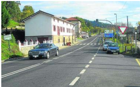
La carretera se renovará a la altura del núcleo de Artxube. FOTO: E. CASTRESANA
